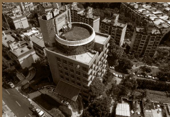
公視 C 棟建築物空拍外觀
