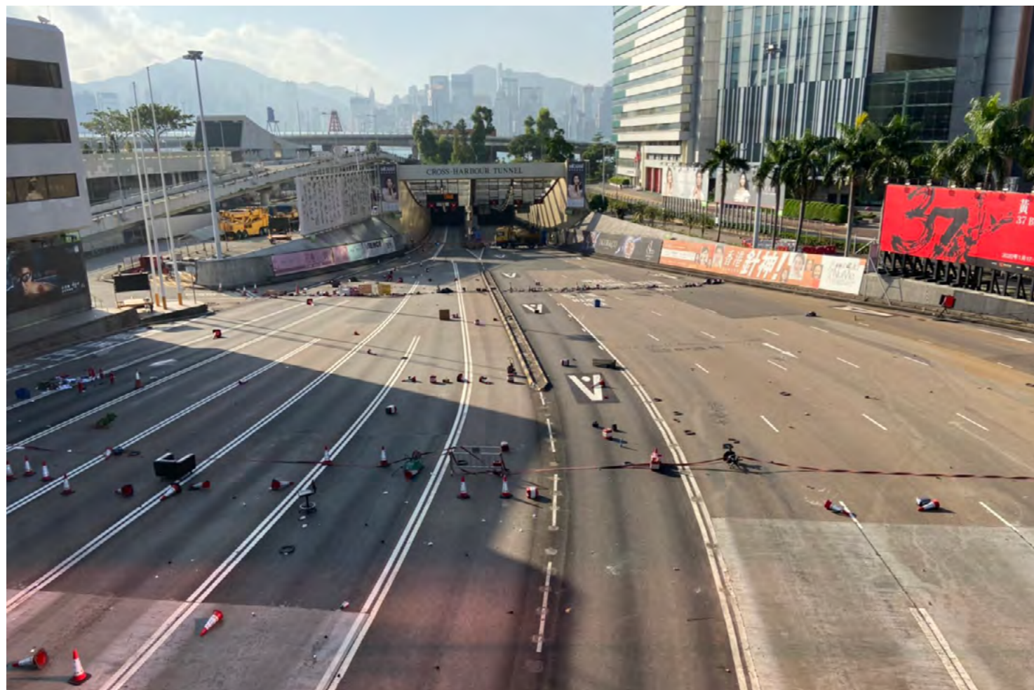
▲ 封閉的紅磡海底隧道
