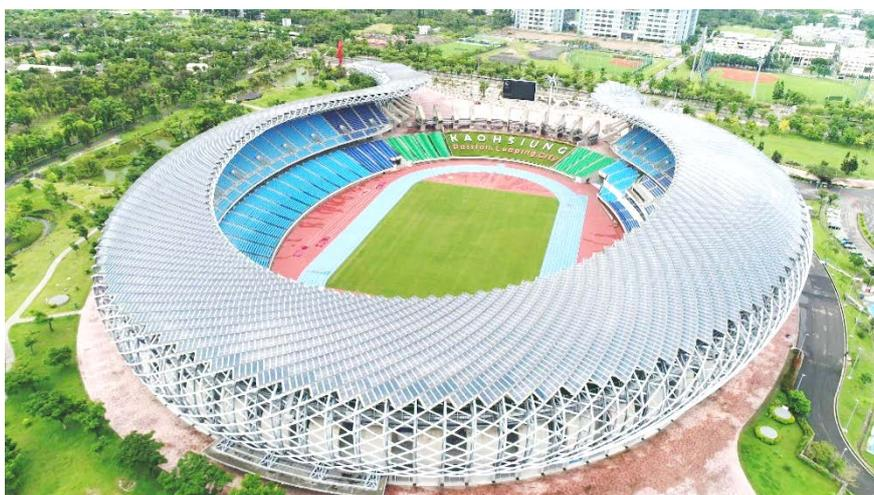
圖說：高雄世運主場館，是世界首座百萬瓦級太陽能發電的運動場。
