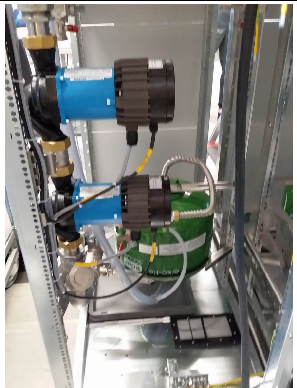
數位發射機後面水馬達系統解說
