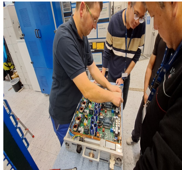
電源講解拆換
